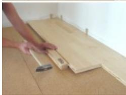
(5) Klopfen Sie mit Hilfe eines Schlagklotzes auf die längsseitige Nut, bis sich die Diele absenkt. Drücken Sie nicht einfach die Diele herunter! **Durch das Klopfen unterstützen Sie den Formschluss der FIX-Verbindung** und Sie erreichen einen optimalen Fugenschluss.
