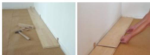
**Erste Reihe:**(1) Legen Sie die erste Diele in die linke Raumecke **mit der Federseite zur Wand**. Arbeiten Sie von links nach rechts. Abstandskeile für Dehnfuge zur Wand (ca. 1 cm) längs- und stirnseitig verwenden.
