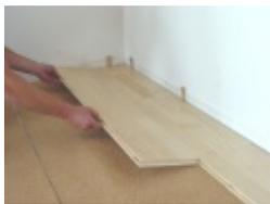
(4) **Abstandskeil an die linke Wand anlegen.** Verwenden Sie das Reststück der ersten Reihe als erste Diele der zweiten Reihe. Der Stirnkantenversatz der Dielen von der ersten zur zweiten Reihe muss mindestens 30 cm betragen. Das Reststück längsseitig in die Verbindung einlegen. Dabei wird die **Feder in die Nut der verlegten Diele lose eingelegt**, sodass oberseitig die Fuge zwar dicht, die Diele aber **noch nicht abgesenkt** ist.
