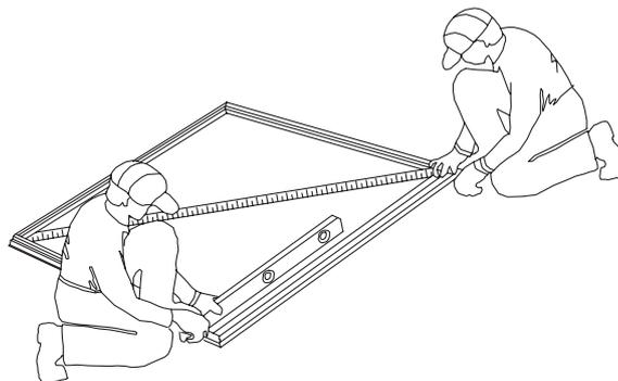
**3** In alle Richtungen wie auf der Abbildung gezeigt vermessen. Vergewissern Sie sich, dass die Bodenrahmenmontage perfekt rechtwinklig ist.
