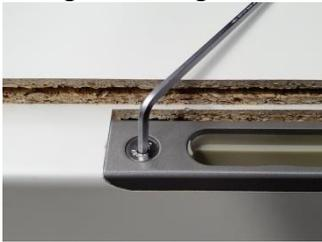
19. Z-Winkel mit beiliegenden Inbusschrauben mit dem Schließblech verschrauben
