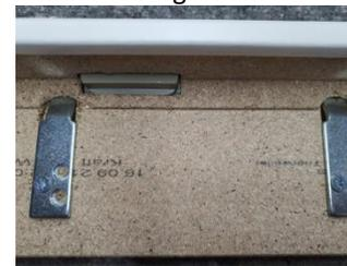
12. Z-Winkel parallel ausrichten und mit je einer 5x20 mm Schraube pro Winkel befestigen
