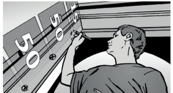
**9** **DE:** Bohren Sie die Dübellöcher. Die Fuge zwischen dem Elementrahmen und Mauerwerk im Bereich der Befestigungspunkte mit Klötzchen hinterfütern.
