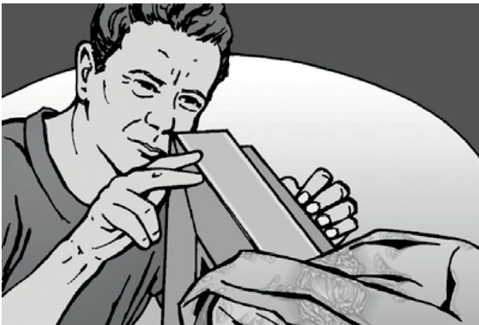
**2** **DE:** Unebenheiten in der Laibung, sowie Schäden oder Rückstände durch den Ausbau alter Elemente ausbessern. Bei Türen darf die Bodenschiene nicht hohl liegen, sie muss mit Mörtel unterfüllt sein.
