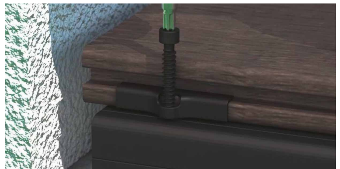
Alle übrigen Befestigungen erfolgen versteckt in den Fugen mit System49 Verbindungsclips.
